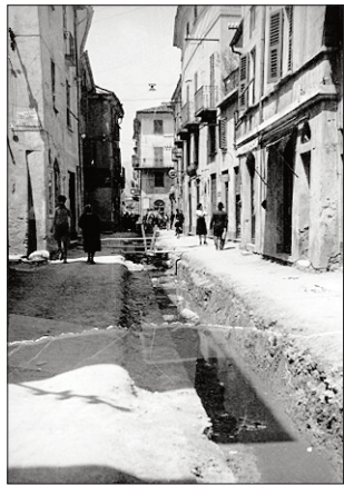
1948, costruzione della fognatura e della pavimentazione in via Roma a Cairo.
